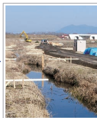
改修工事 (現在の様子)
